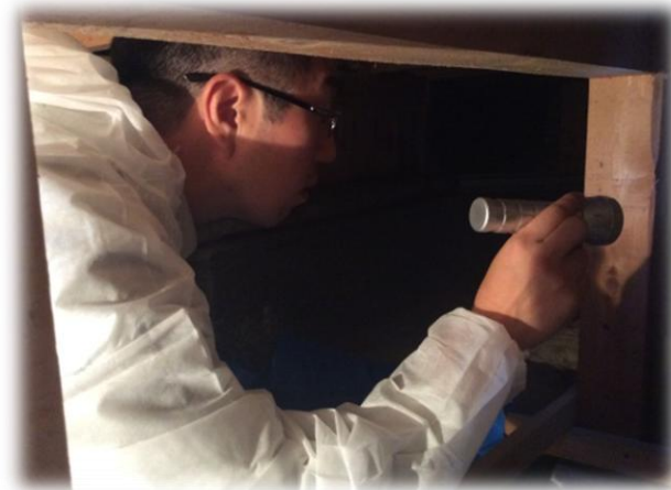
小屋裏・床下の状況を確認
